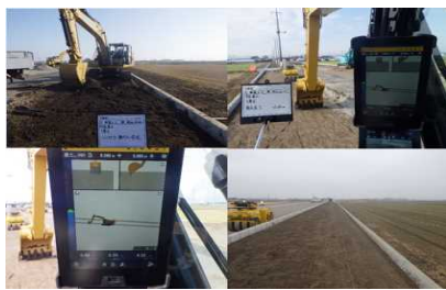
【ICT建機による盛土状況】
