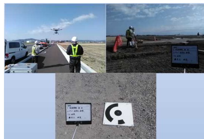
【UAVによる出来形検測】
