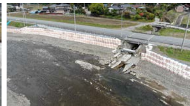
栃木市星野町「新栗生橋」
