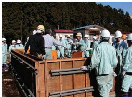
▲袖壁の配筋および型枠の製作
