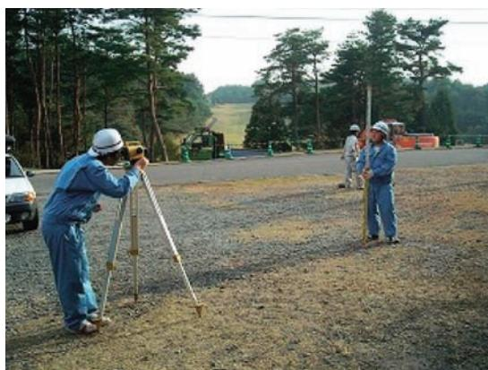
▲防火水槽設置工事現場における水準測量
