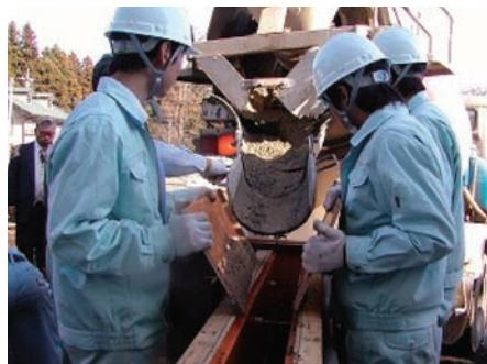
▲袖壁へのコンクリート打設
