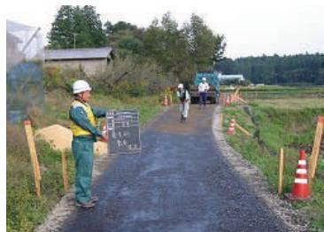
次に、振動ローラー、タイヤローラーによる転圧作業を水を散布しながら最適含水比に近い状態で行った。ディストリビューターでプライムコートの散布を行い、その上に養生砂の散布を行い、路盤が完成した。プライムコートの散布量は1.26リットル/m<sup>2</sup>で設計されており、実際の散布量の測定も行った。
