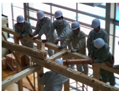
羽子板ボルトで柱・梁を固定
