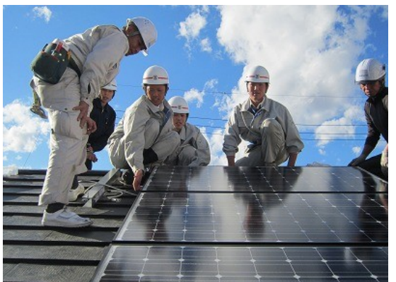
モジュール設置工事
