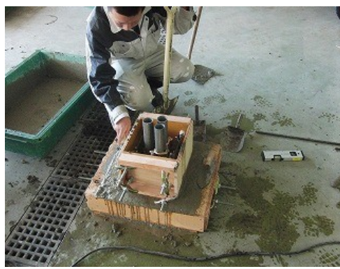
コンクリート打設
