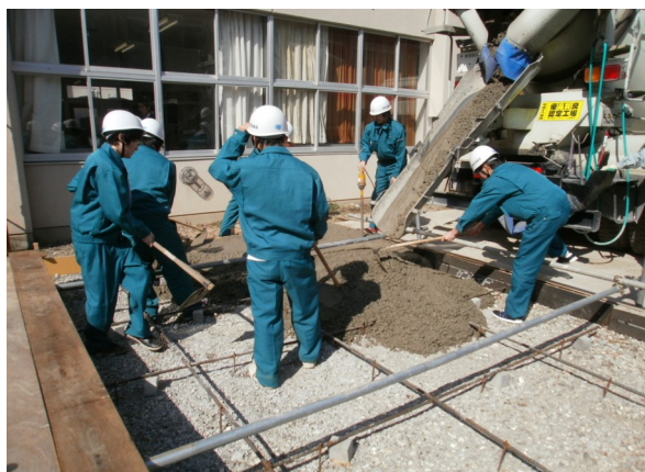
コンクリート打設
