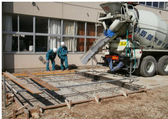
コンクリート打設
