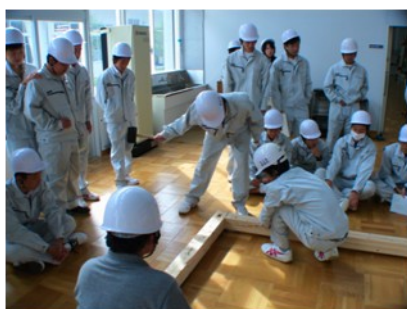
土台の取り付けでは、大矩を使用して直角に配置
