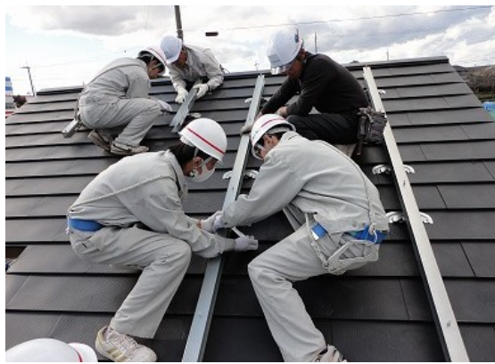
フレーム取付工事
