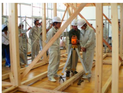
自動レベルを使用して水平を確認
