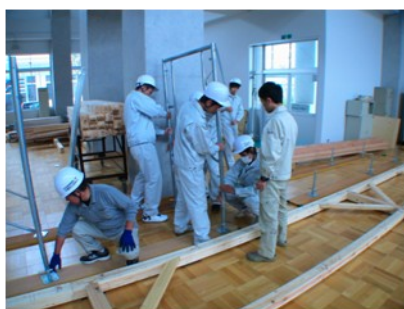
高所作業のため建物の周囲に足場を設置
