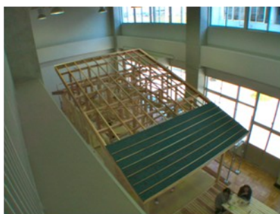
屋根の一部を製作
