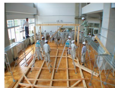
柱・梁を建て、仮筋交いで固定
