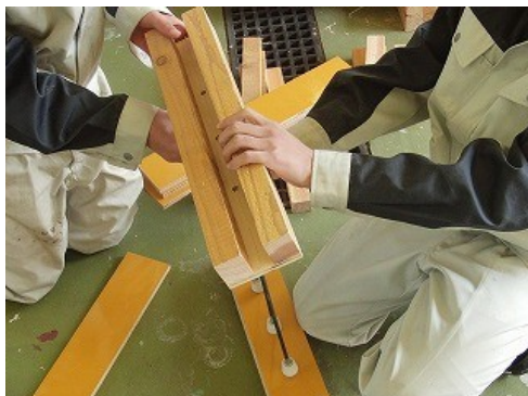
型枠の組み立て
