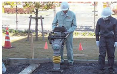
地先ブロック部分の基礎締め固め
