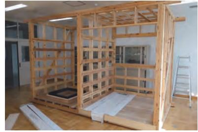
窓を入れる箇所に、窓台、窓まぐさ、間柱を入れ、軸組部分の完成
