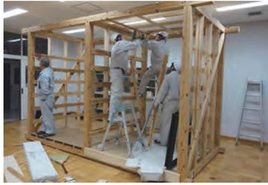
筋かいを入れ、水平を出した後に間柱を入れ、貫を入れる。その後、天井を組み上げる
