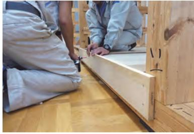
床組の上に床下地、床仕上材を貼る
