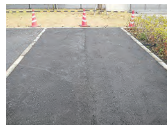
⑮アスファルト舗装完成
