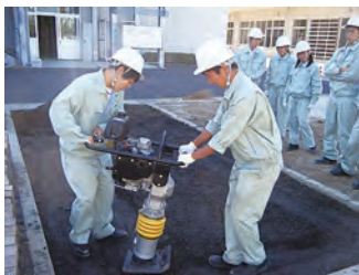
④ランマー締固め作業
