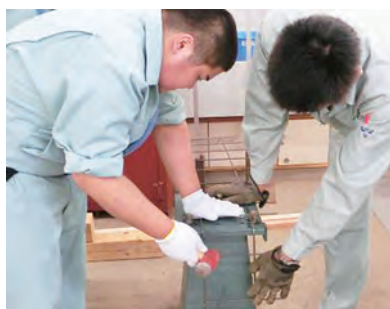
鉄筋の加工
