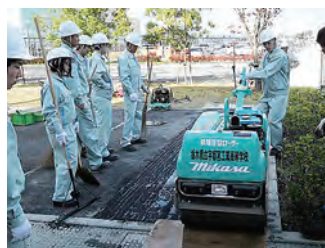
⑭ローラー転圧作業
