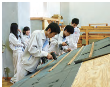
アスファルトルーフィングを敷き、瓦棧を付ける
