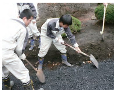
碎石の敷均し
