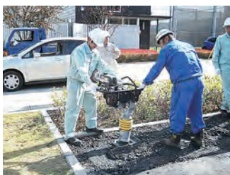
⑬ランマー締固め作業
