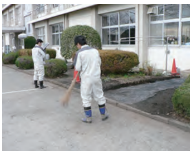
碎石の転圧作業終了
