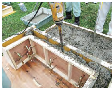
コンクリート打設 2
