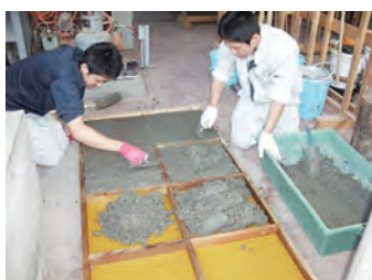
コンクリート平板製作
