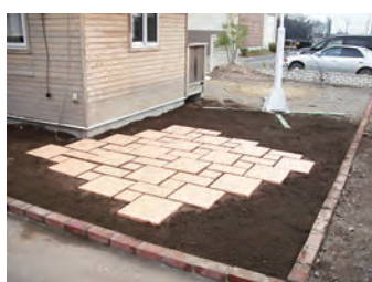
コンクリート平板設置
