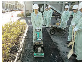
⑪コンパクター締固め作業
