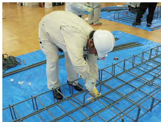
■鉄筋組立作業
