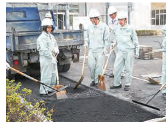
⑫アスファルト投入
