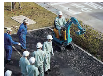
⑨アスファルト舗装路床準備
