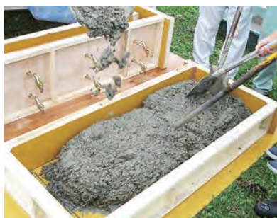
コンクリート打設 1
