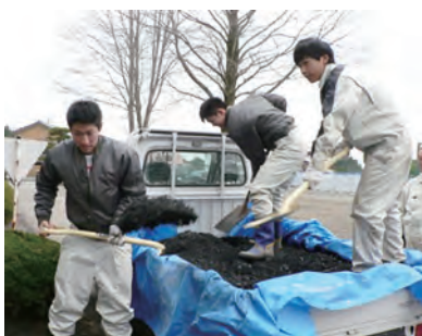
碎石の敷ならし
