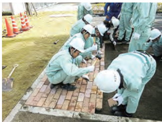
⑦インターロッキング設置
