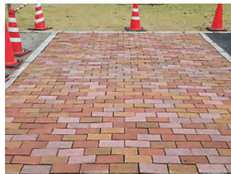
⑧インターロッキング舗装完成
