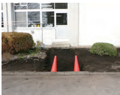
掘削作業終了
