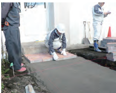
インターロッキングブロックの敷設
