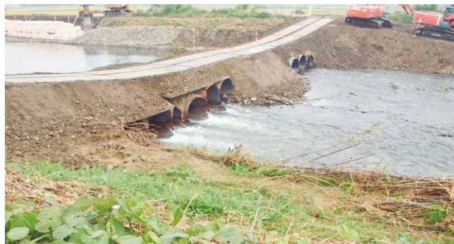
現場に土を搬入するために仮設道路を設置（壬生町 姿川 淀橋下）
