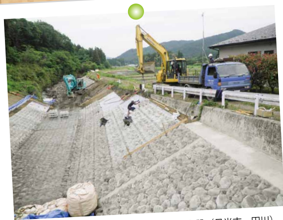
大雨で洗堀された川岸に連結ブロックを布設（日光市 田川）
