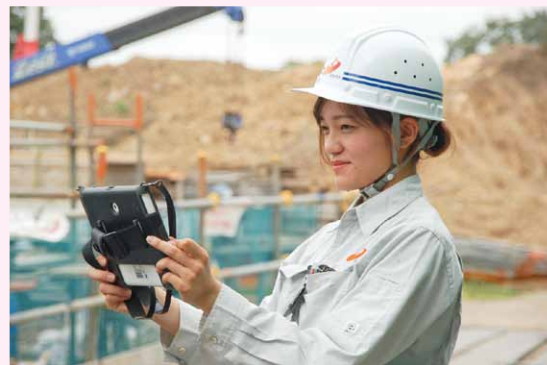
タブレットを使用した現場管理
