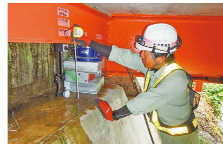
大岩建設の櫻井氏「橋の支取替工事でジャッキアップの高さを確認」
