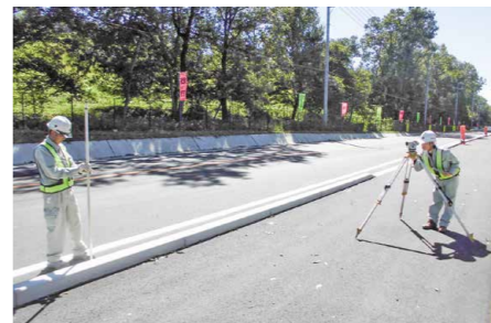
岡工務店の菊池氏（右）「現場が完成した際の出来形を測量」
