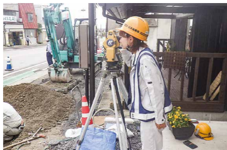
櫻本建設の櫻本氏「歩道内に共同溝ボックスを設置するための位置出しを行う」
