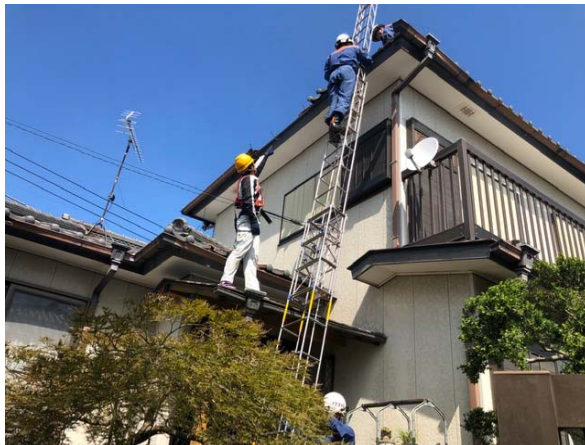
【ブルーシートの作業状況(木更津市)】
