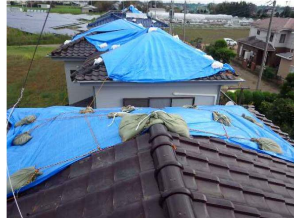
【ブルーシートの設置状況(八街市)】
