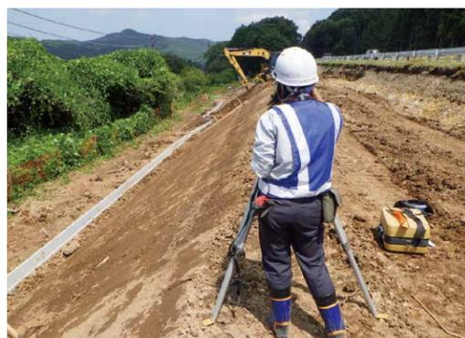
板橋組の大橋圭さん。埋設工事の掘削した高さを実測
