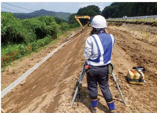
板橋組の大橋圭さん。埋設工事の掘削した高さを実測
