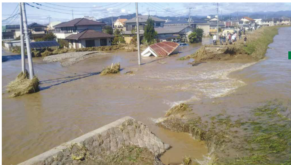
① 被災直後（決壊状況）
