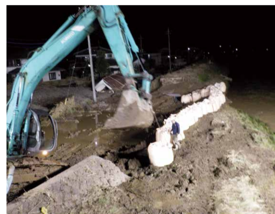
[18:58] 住宅地への水流侵入防止措置
