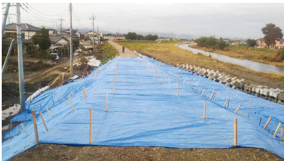
④ 防水シート設置完了
