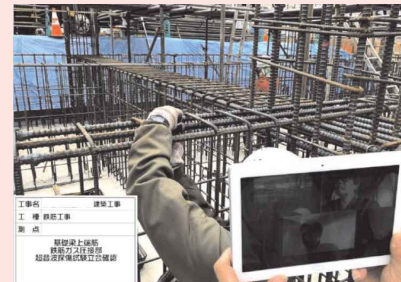
Webカメラを利用した遠隔検査
