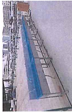
現場の手洗い場所の増設
