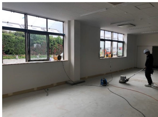
【写真①】送風機による換気(室内側)
