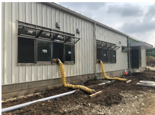
【写真②】送風機による換気(室外側)
