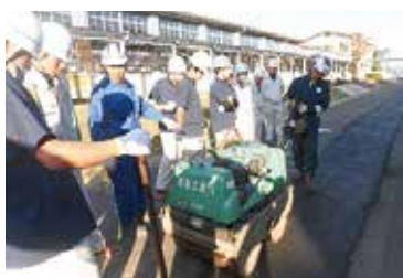
⑧ローラー転圧
