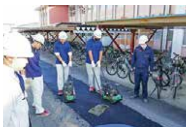
⑦締め固め
