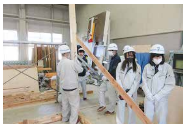
仮筋交いの取付け
