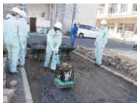
プレートコンパクターによる転圧
