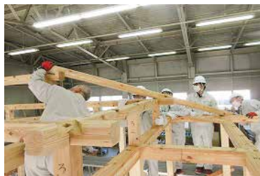
隅木の取付け
