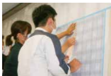
内装工事②
