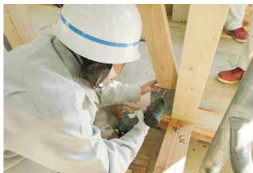
筋交い取付け
