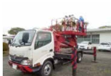
鳶土工事③ 高所作業車
