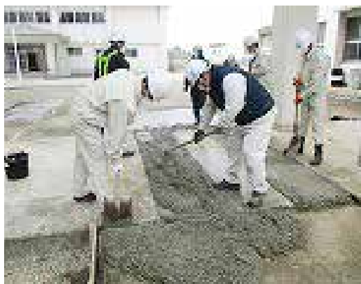
作業の様子（打設）
