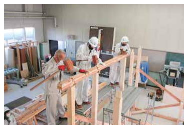
軒桁の取付け
