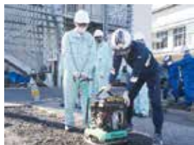
プレートコンパクターによる転圧
