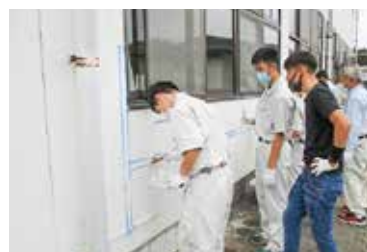
防水工事②
