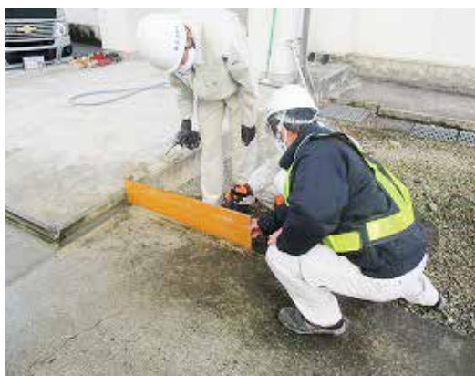
作業の様子（型枠設置）
