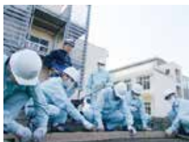
敷砂の敷き均し
