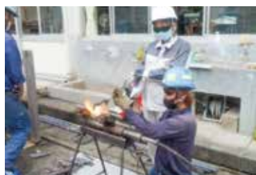
鉄筋工事③ ガス圧接
