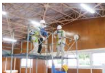
鳶土工事②
