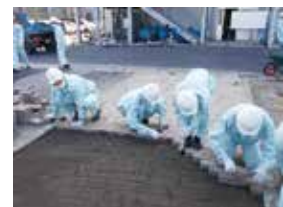
ブロックの敷設
