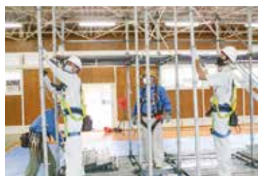
鳶土工事①
