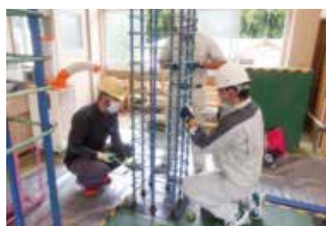
鉄筋工事①
