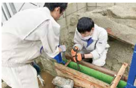
コンクリート打設
