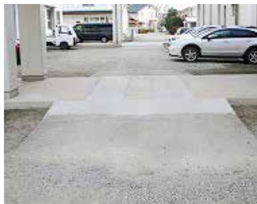
施工後の様子
