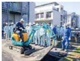
舗装のはつり
