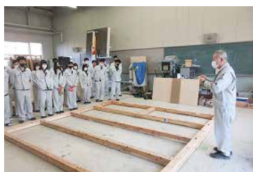
土台の据え付け
