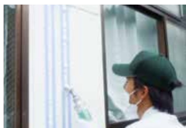
防水工事①
