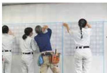
内装工事①
