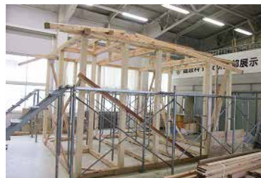
建て方実施後
