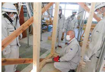
火打ち土台取付け
