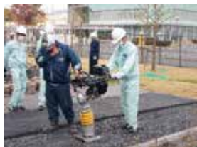
ランマーによる転圧
