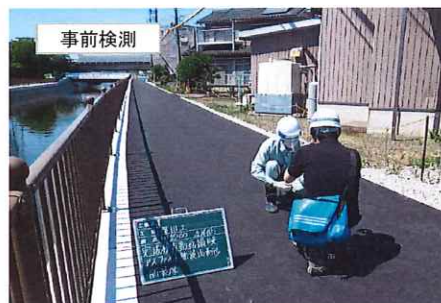
竣工検査をリモートで実施 (完成図書はクラウド上で確認、出来形は事前に発注者で検測等の工夫を実施)
