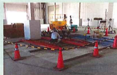
工事エリアの区画を設定して作業
