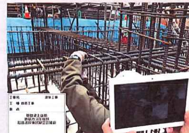
Webカメラを利用した遠隔検査
