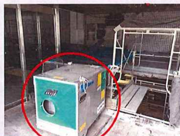
集塵機を設置し室内の換気を実施
