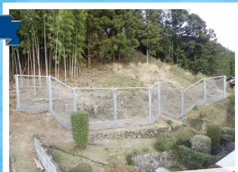
崩壊土砂防護柵工事（足利市）
