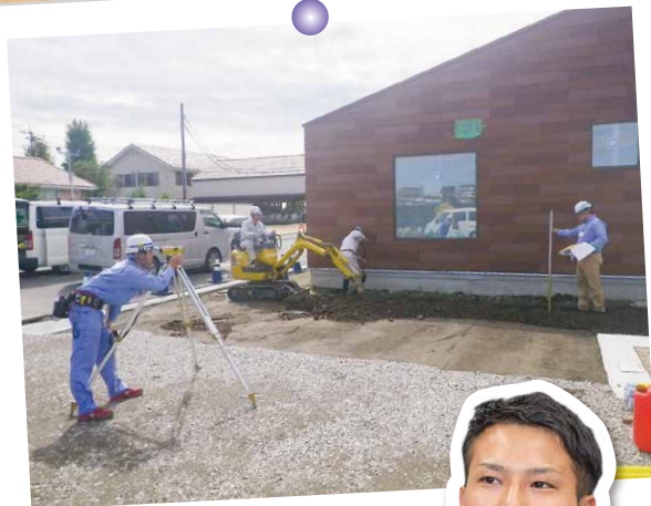
埋設工事の掘削した高さを実測
