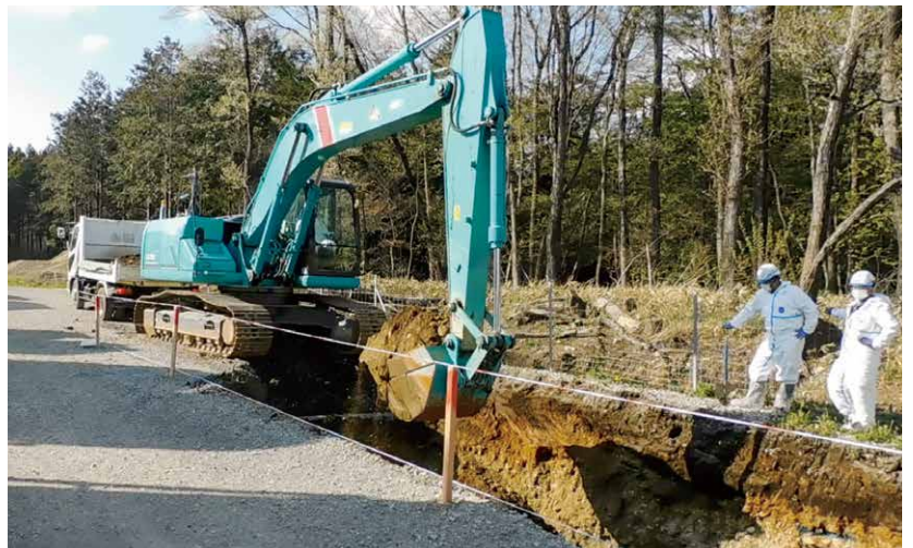
豚を埋却するための掘削作業
