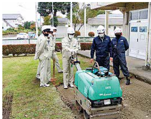
路盤の転圧作業
