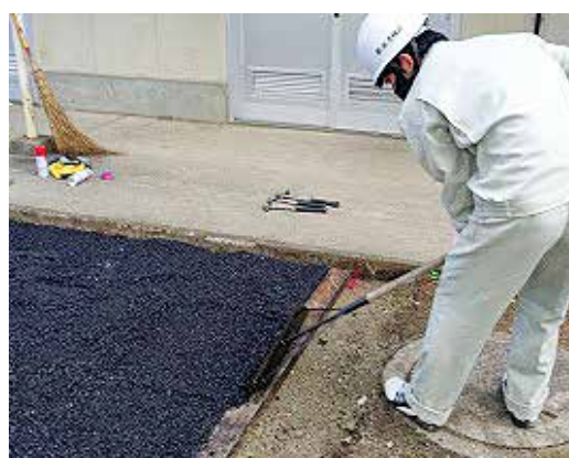
アスファルト合材の敷き均し作業
