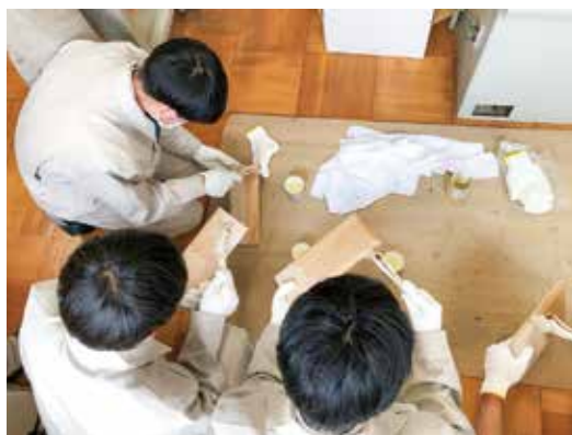
自然塗料による塗装作業
