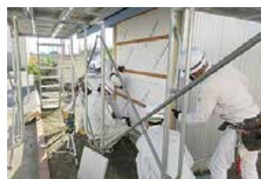
外壁取付け位置の墨出し
