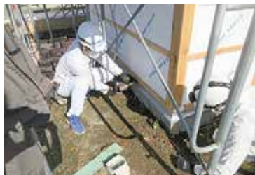
土台周り水切り取付け
