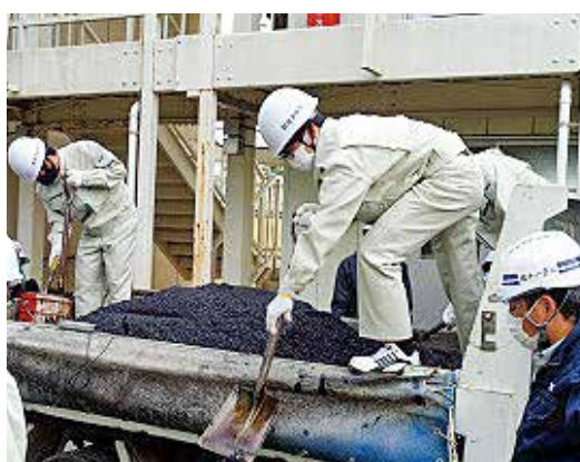
アスファルト合材の運搬作業
