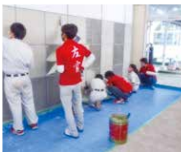
鉄筋工事⑧
