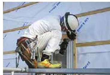
窓周り水切り取付け
