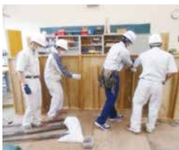
鉄筋工事⑦
