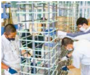
鉄筋工事②
