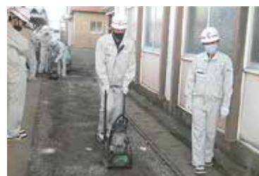
⑥転圧作業
