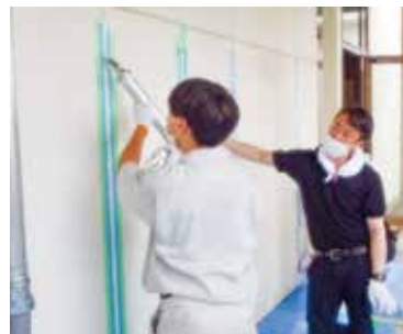
防水工事②
