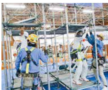
鉄筋工事④
