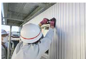
窓枠キャップの取付け
