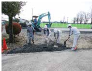
砕石の敷均し作業
