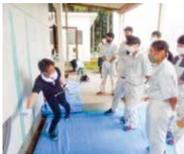
防水工事①
