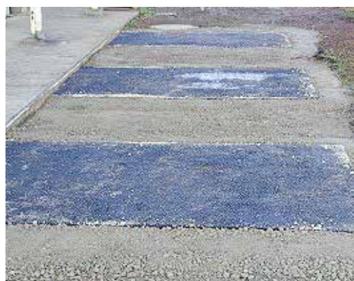
施工後の様子
