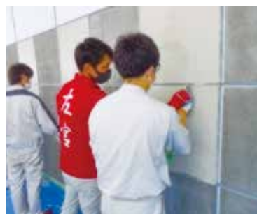
鉄筋工事⑨
