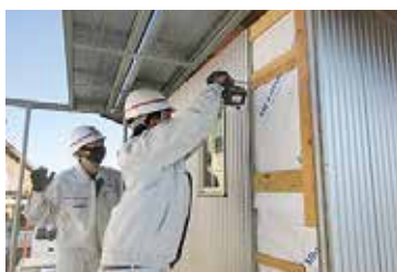
外壁取付け①
