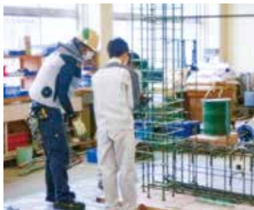
鉄筋工事①
