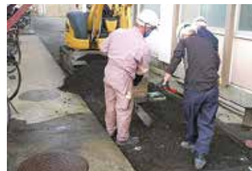
③掘削・床付
