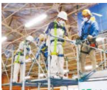
鉄筋工事⑤
