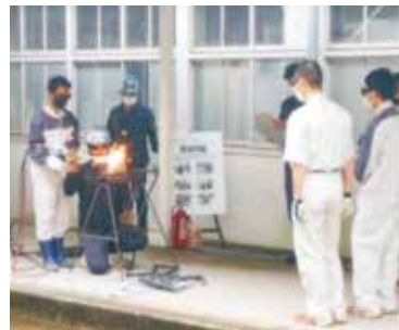
鉄筋工事③ ガス圧接
