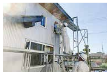
外壁取付け②
