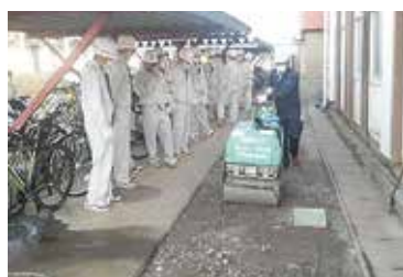
⑧ローラー転圧
