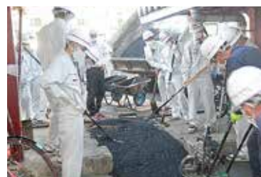
⑫レーキによる敷均し
