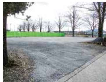
駐車場不陸工事完了
