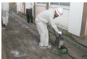
⑦細部の転圧
