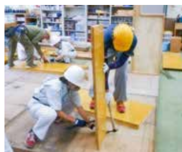
鉄筋工事⑥
