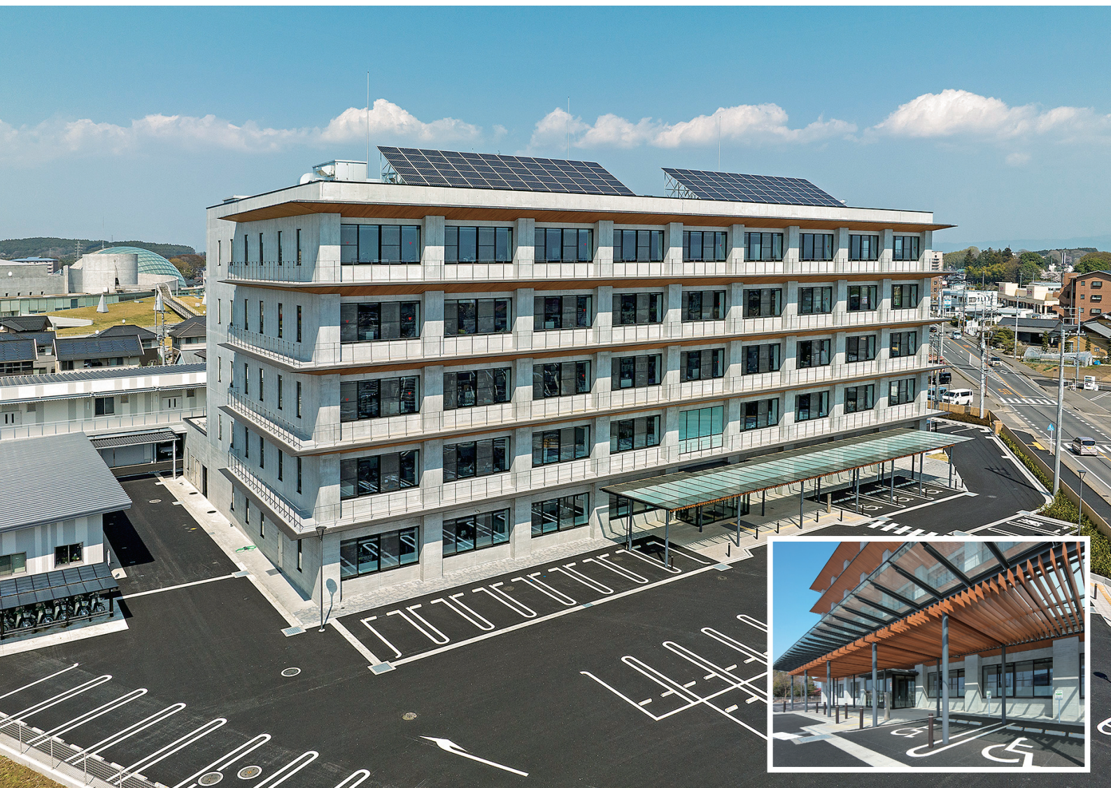
「栃木県庁那須庁舎」(令和5年1月13日竣工) (写真提供: 栃木県 県土整備部 技術管理課)
