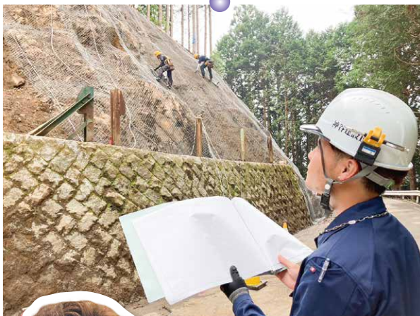
法面工事の現場管理を行っています。
