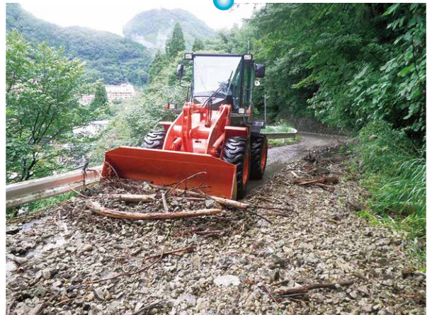
平成27年9月関東・東北豪雨 災害復旧作業
