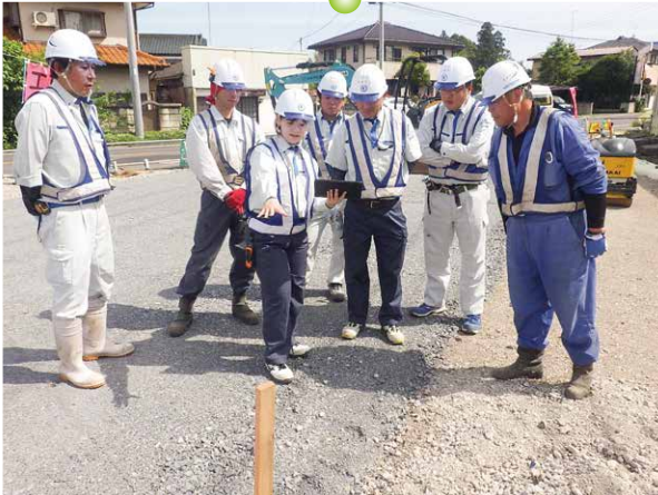
3Dデータを用いて道路線形を確認しています。
