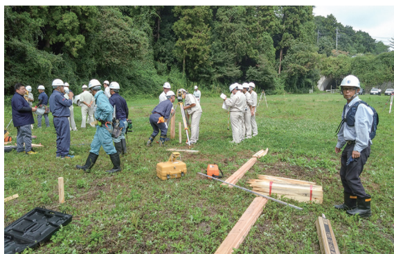
測量実習 土木
