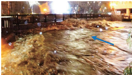
写真1 令和元年東日本台風時 宮の橋
