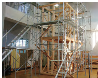
木造2階建て建物（仮組み）
