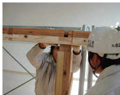
柱と桁の取り付け
