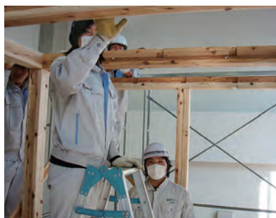
梁を取り付ける
