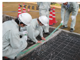
鉄筋配置と地先ブロックの保護
