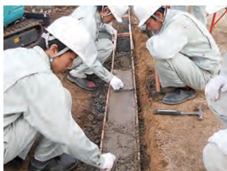
地先ブロック下部の基礎打ち
