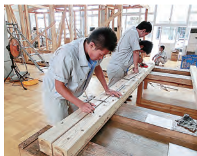
図面を見ながら墨付けを確認する
