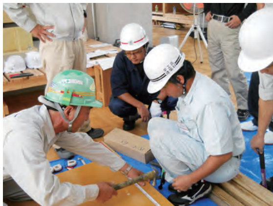
型枠製作作業
