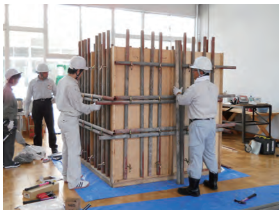
単管パイプ取付
