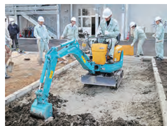
セメント散布による地盤改良
