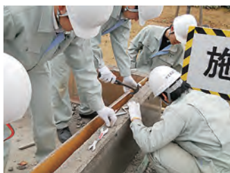
型枠の脱型
