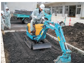
碎石の敷ならし
