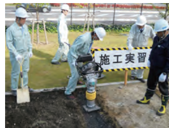
地先ブロック部分の基礎締め固め
