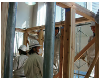
仮筋交いを取り付け、桁を乗せる
