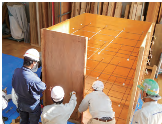
型枠組立作業
