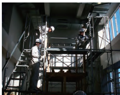
高所作業のため足場を設置
