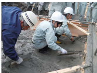
コンクリートの敷ならし
