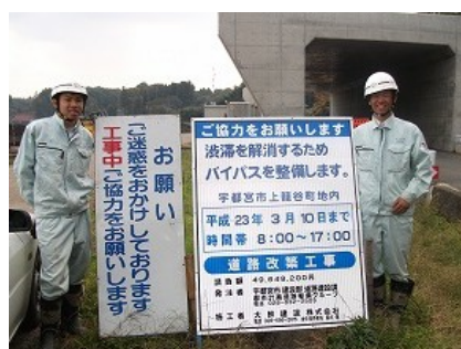
道路改築工事現場
