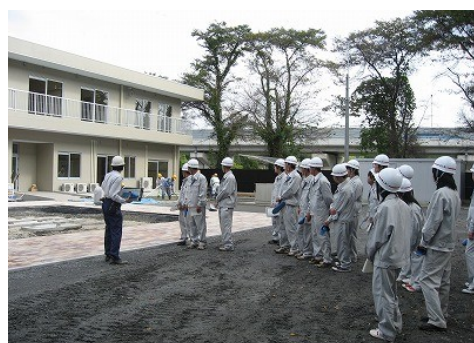
女性自立支援センター(仮称) 新築工事
