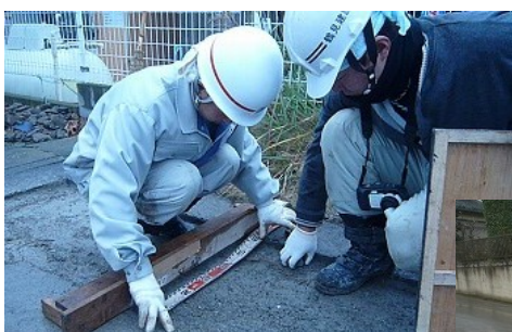
4 路盤の幅・高さの確認
