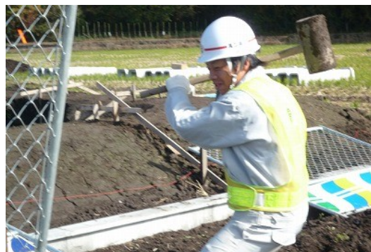
杭の打ち込み
