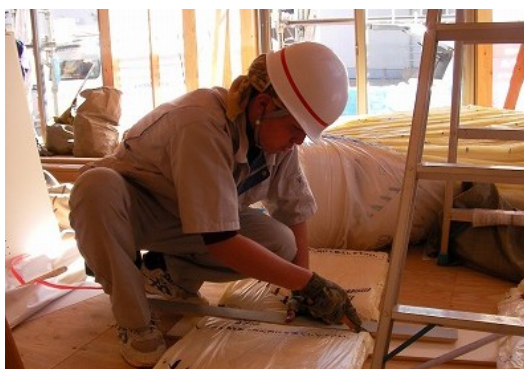
断熱シート切り
