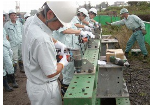
高力ボルト締め付け機体験
