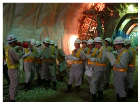
付替県道4号トンネル工事
