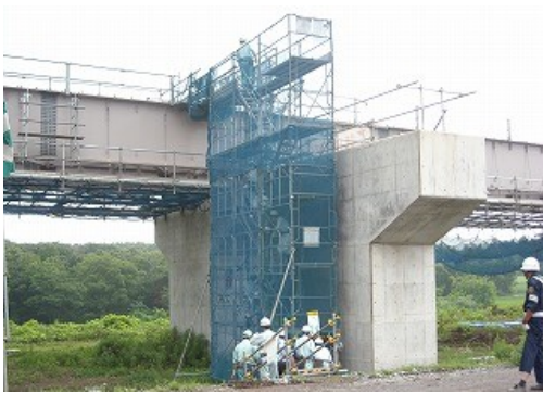
安全帯を着用しての高所見学
