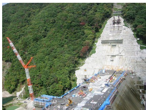
湯西川ダム本体建設工事 重力式コンクリートダム
