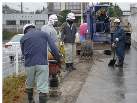
3 敷き均し・締め固め
