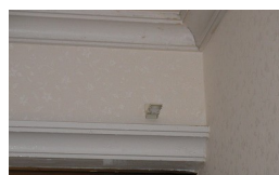
レール金具取り付け
