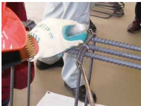
鉄筋結束作業
