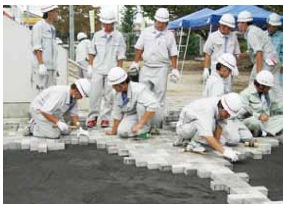
インターロッキング舗装工事
