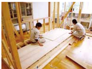
床・壁下地材の取り付け
