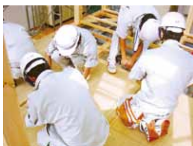
床下地材の取り付け
