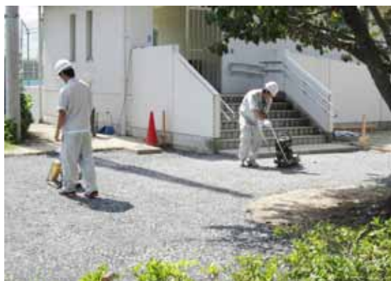
締固め工事
