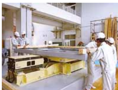
振動台に拡張テーブルを設置し、土台を配置
