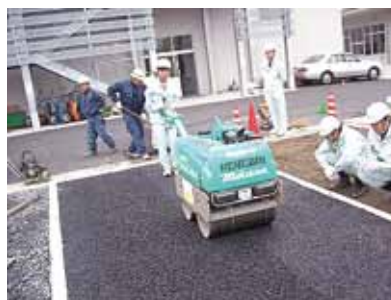
排水性舗装 施工状況
