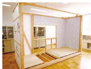
内装実習後の壁紙仕上（完成）
