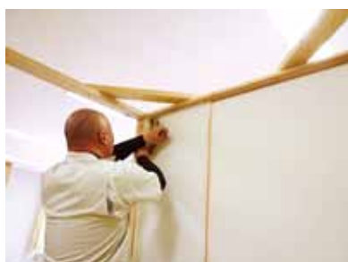
ブースを利用したの教員指導 (壁紙長尺の貼り方)
