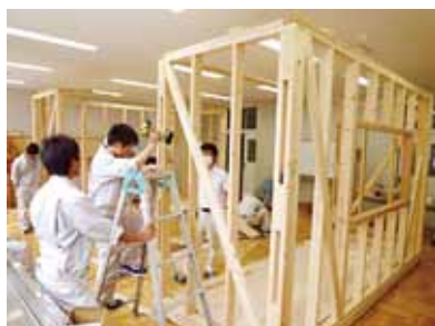
立て直しを行い建方終了
