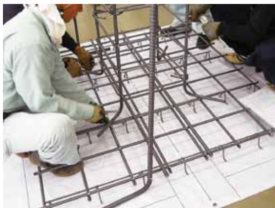
鉄筋組立作業
