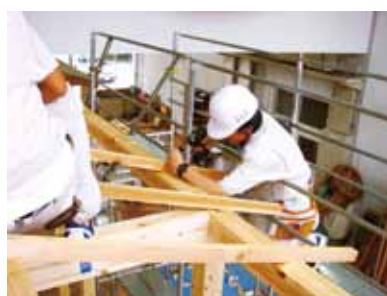
小屋組・垂木の取り付け
