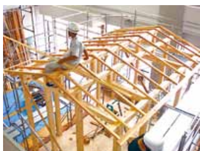
小屋組の完成
