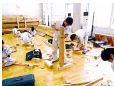
柱と梁の組立作業を行う
