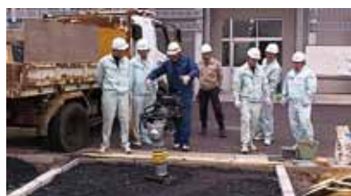
転圧作業説明
