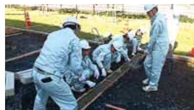
基礎コンクリート打設
