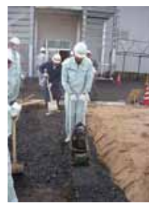
地先ブロック部分の基礎締め固め
