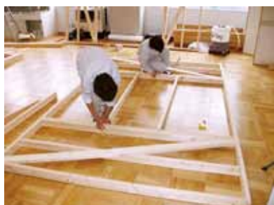
2×4工法による壁面製作
