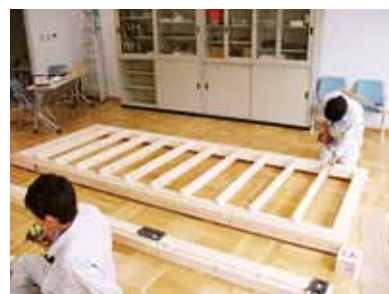
根太掛けと根太の取り付け
