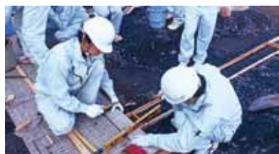
基礎コンクリート型枠設置
