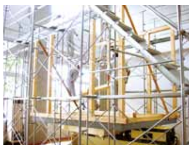
柱や梁の主要構造部の取り付け
