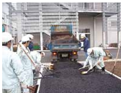
アスファルト舗装施工
