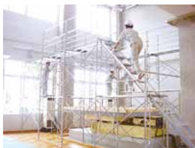
高所作業のための足場を設置
