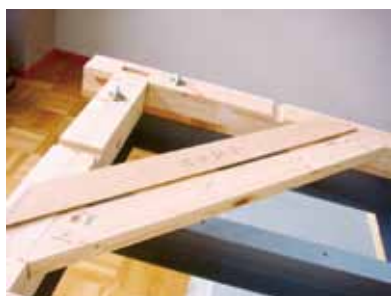
四隅に火打ち台を固定
