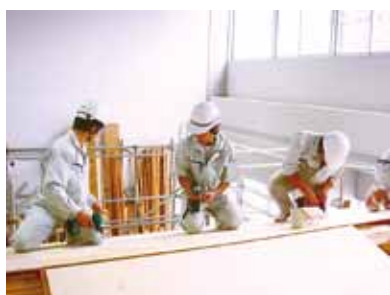
野地板の固定
