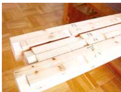
材料の墨付けと加工
