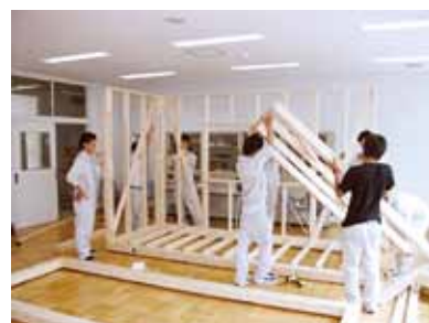
木造枠組壁式工法での組み上げ
