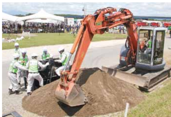
大型土のうを製造する宇都宮支部
