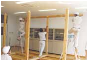
④柱を立て、梁を入れる
