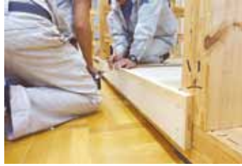
⑧床組の上に床下地、床仕上材を貼る
