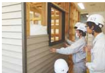
⑪外壁材（サイディング）の取り付けを行う
