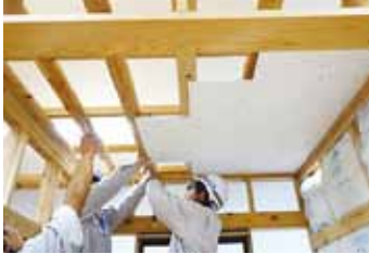
⑦天井仕上材を張る
