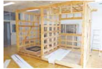
⑥窓を入れる箇所に、窓台、窓まぐさ、間柱を入れ、軸組部分の完成
