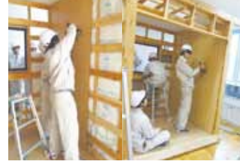
⑨内壁を貼る
