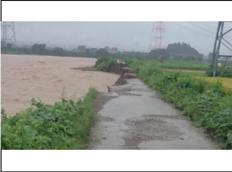
箒川 小種島大橋 下流300m右岸 9月10日 10:35:30 箒川 小種島大橋 下流300m 右岸
