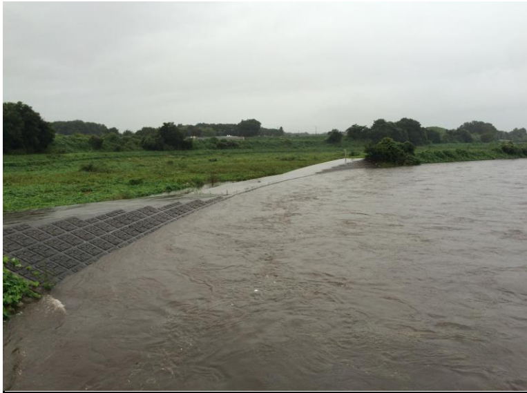
五行川遊水地 右岸側越流堤 9月10日 11:23:57 午前8時頃
