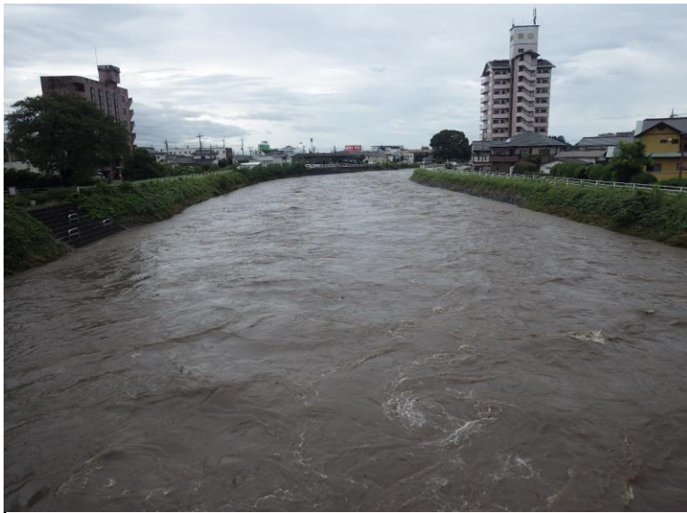
築瀬大橋下流
