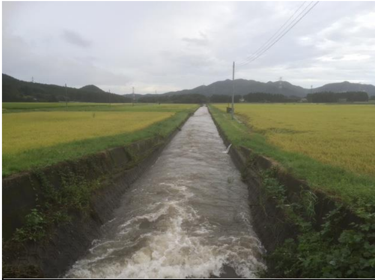
宇都宮市篠井町 9月10日 16:07:36 異常ありません。(平成逆川橋)
