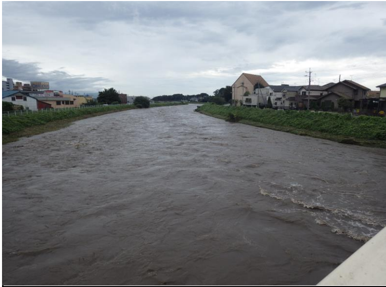
新田川橋下流
