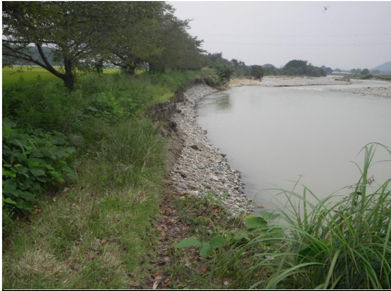
塩谷郡塩谷町 荒川 9月13日 14:11:00 荒川 荒川橋下流 左岸 塩谷町 田所地内
