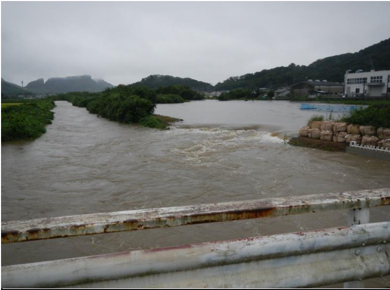
栃木市岩舟町古江地内 9月11日 09:38:27 9月10日午前8時の出水状況です
