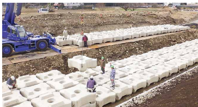
河床に根固めブロックを布設（鹿沼市 行川）
