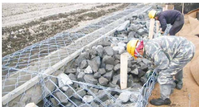
崩落した法面補強で流出した土砂を利用（日光市 岩崎地内）
