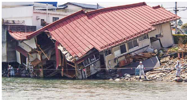
護岸復旧作業前の災害状況を確認（鹿沼市 黒川 御成橋）
