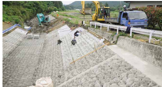
大雨で洗堀された川岸に連結ブロックを布設（日光市 田川）
