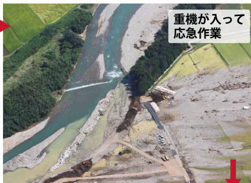
③ 被災その後（応急復旧状況）平成27年10月
