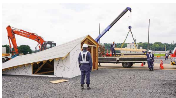
栃木県建設業協会 那須支部等による 『瓦礫等除去訓練』救助・救援活動を妨げる倒壊家屋などの撤去作業
