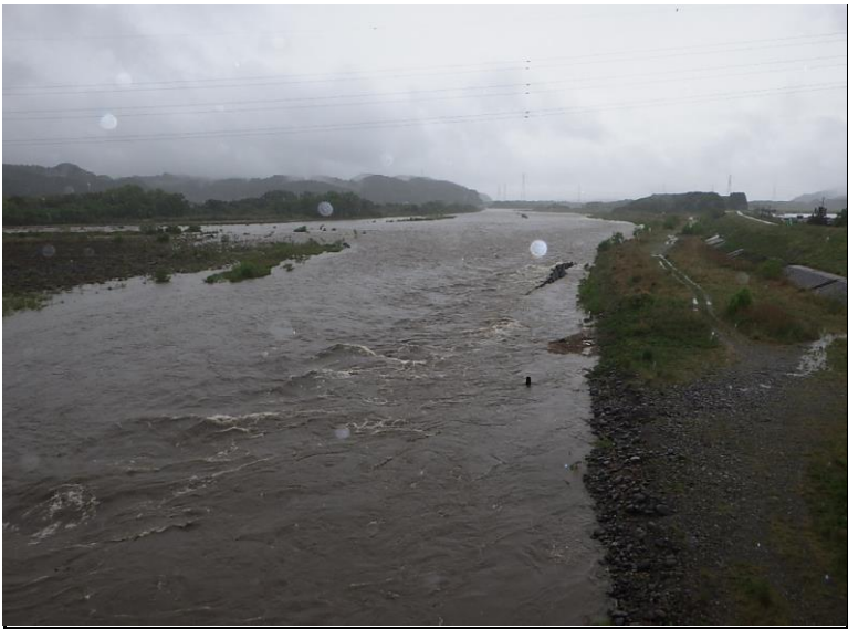
鬼怒川 塩谷町上平 5月21日 鬼怒川 上平橋((主)藤原宇都宮 線)での増水状況
