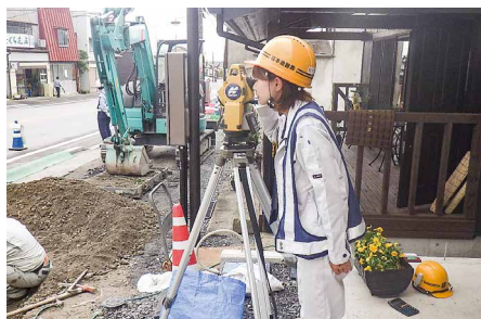
榎本建設の榎本氏「歩道内に共同溝ボックスを設置するための位置出しを行う」
