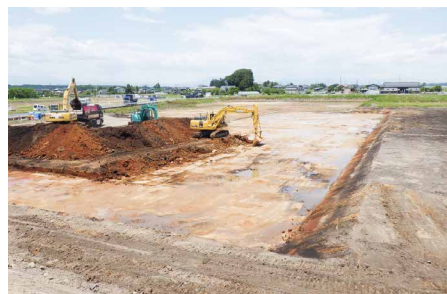
松本建設の金子氏「県内初となるICT活用工事。五行川遊水地掘削工事」
