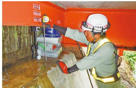
大岩建設の櫻井氏「橋の支承取替工事でジャッキアップの高さを確認」
