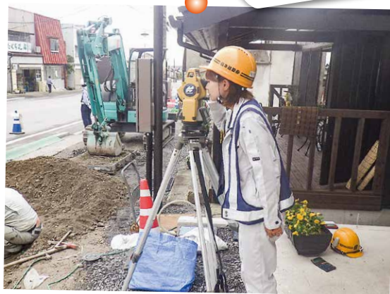
歩道内に共同溝ボックスを設置するための位置出しを行う
