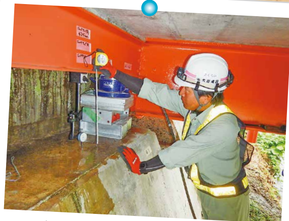
橋の支承受替工事でジャッキアップの高さを確認
