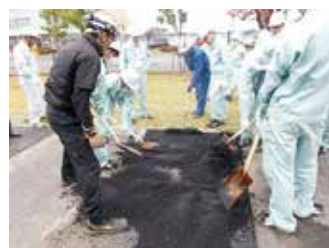
⑥アスファルト投入
