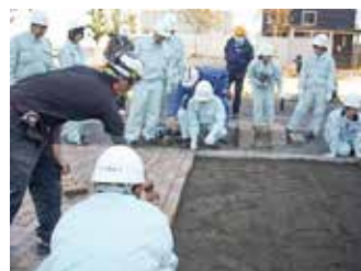
⑫インターロッキング舗装作業
