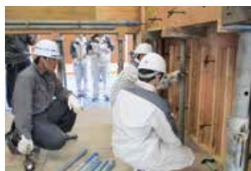
型枠工事②
