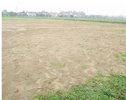
施工後の様子
