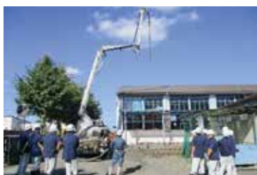
コンクリートポンプ車の見学
