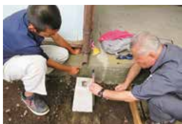
独立基礎据付け
