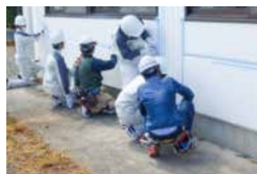
防水工事①
