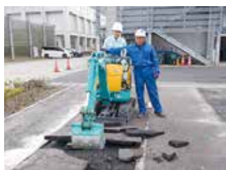
④舗装を剥がす
