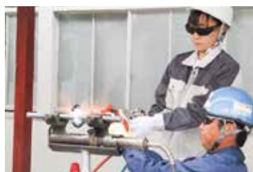
鉄筋工事③ ガス圧接
