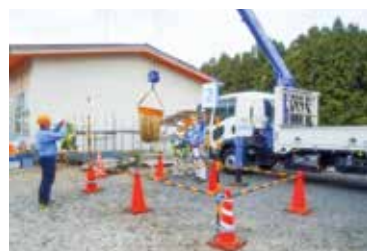
鳶土工事②
