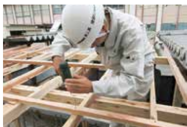
栈木の取付け
