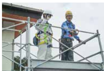
鳶土工事①
