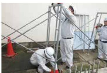
足場の組立て
