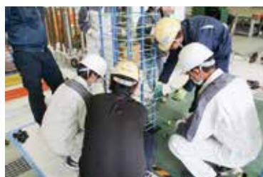
鉄筋工事②
