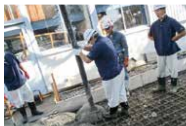
コンクリート打設
