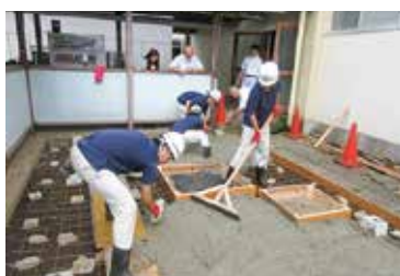
コンクリート打設
