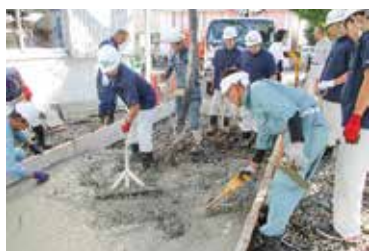
コンクリート均し
