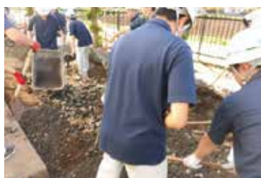
碎石の敷き込み
