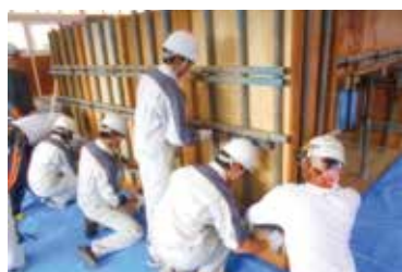
型枠工事①
