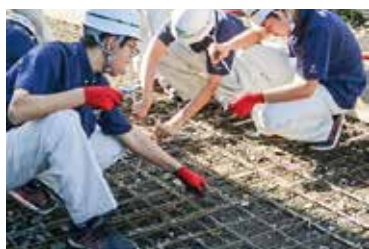
ワイヤーメッシュや鉄筋の敷設
