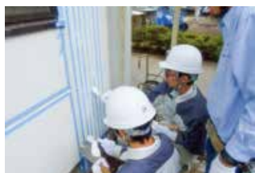
防水工事②
