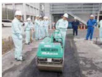
⑦ローラー転圧
