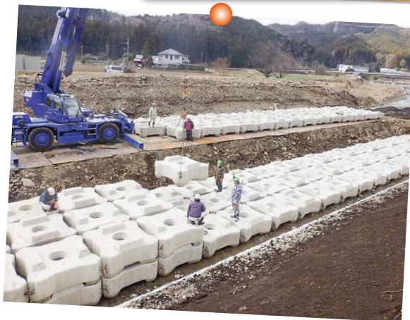
河床に根固めブロックを布設
