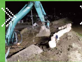
③住宅地への水流侵入 防止措置 18:58
