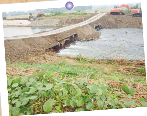
現場に土を搬入するために仮設道路を設置
