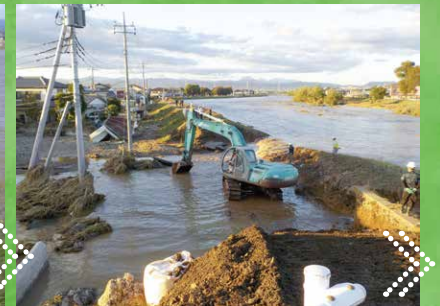
②応急仮復旧工事状況
