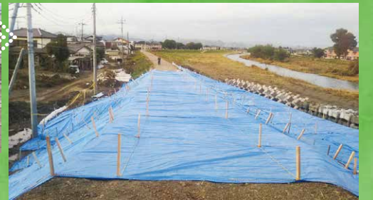
⑤防水シート設置完了 令和元年10月24日
