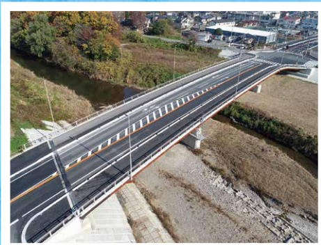
舗装工事 (足利市)
