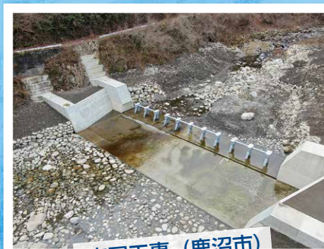
床固工事 (鹿沼市)
