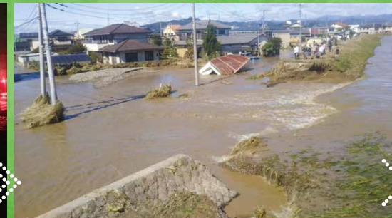
①被災直後 (決壊状況) 令和元年10月13日
