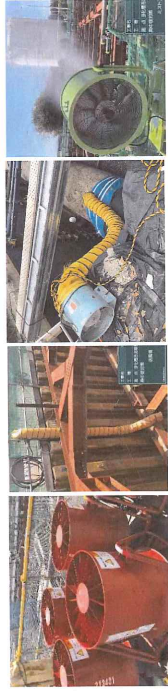
送風機により通気性を確保するとともに、ドライミスト発生装置等も併用
