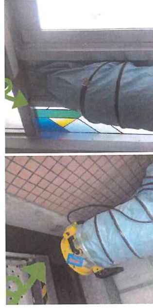
内装工事において、送風機及び冷却器を使った換気を実施
