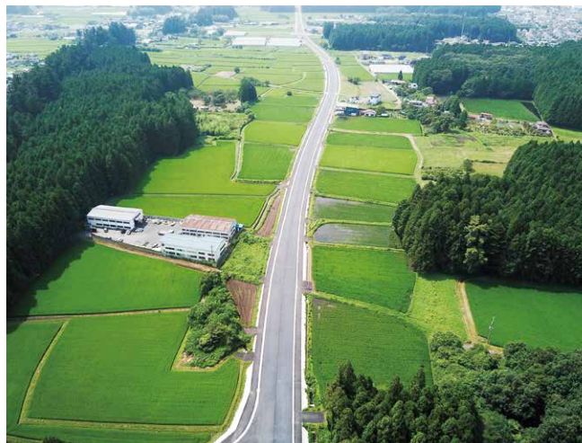
受賞対象となった国道119号 水無バイパスの舗装工事現場
