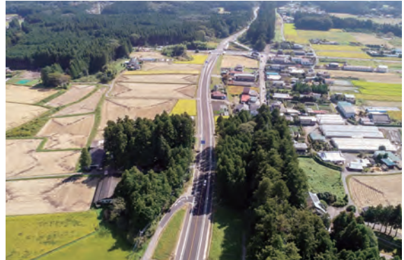
▲完成した水無バイパス
